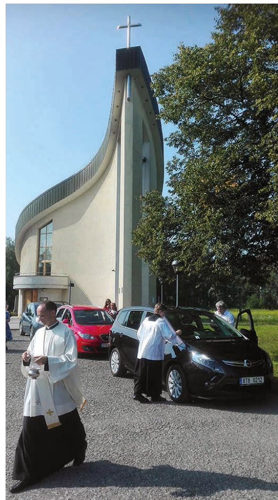
Kostel sv. Barbory v Karviné-Loukách z roku 2001 nahradil původní kostel sv. Barbory, který nebylo možné používat kvůli důlním vlivům. Otec Roland před tímto kostelem letos v létě požehnal motoristům jejich vozidla. Foto: Farnost Stonava a Louky
